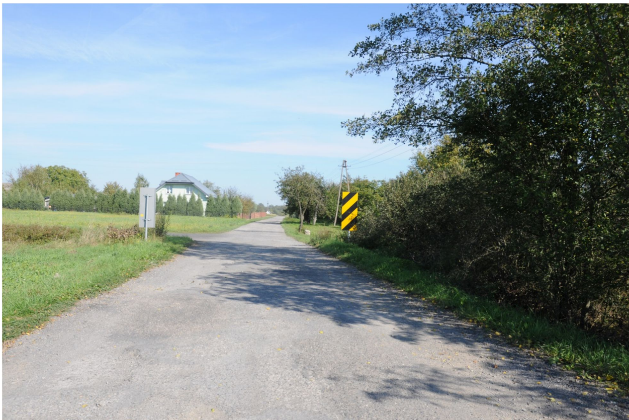
Stan drogi gminnej nr 103626L. Widoczne zwężenie skrajni na przepuście w km 0+546,00
